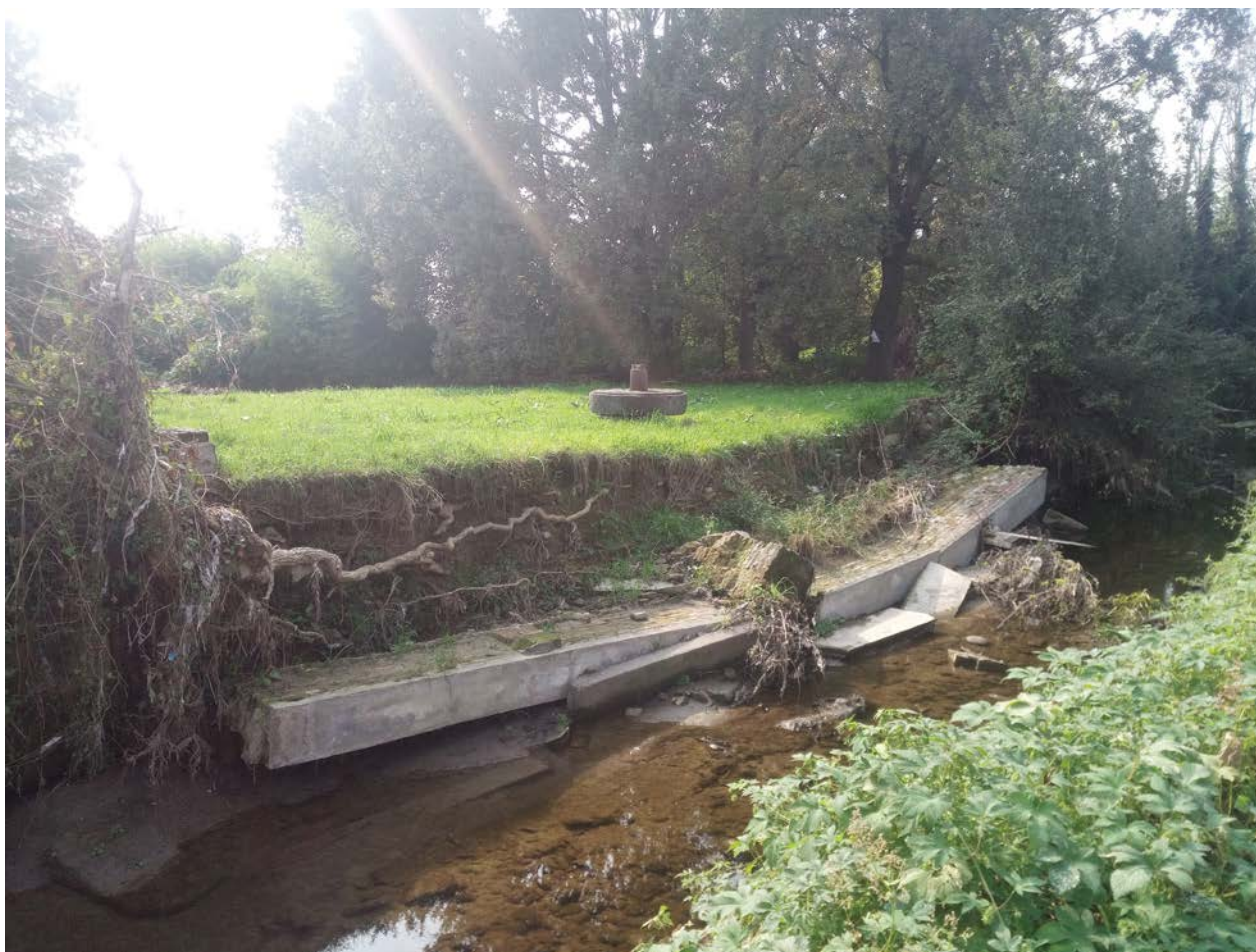
Figura 27: tratto di muro arginale recentemente crollato all'interno della Molinara a seguito delle piene di settembre
