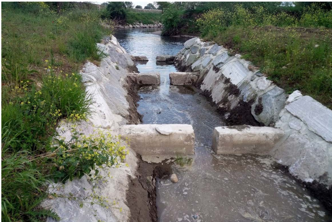
Figura 12: nuova rampa di risalita Golena 2
