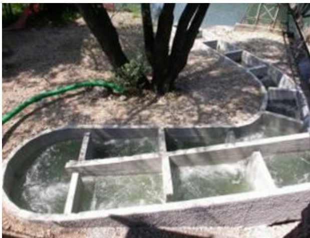
Figura 14: esempi realizzativi di passaggi artificiali per pesci a bacini successivi
