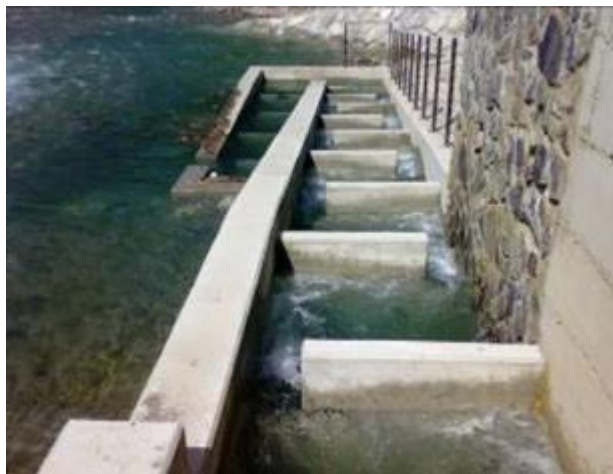
Figura 14: esempi realizzativi di passaggi artificiali per pesci a bacini successivi
